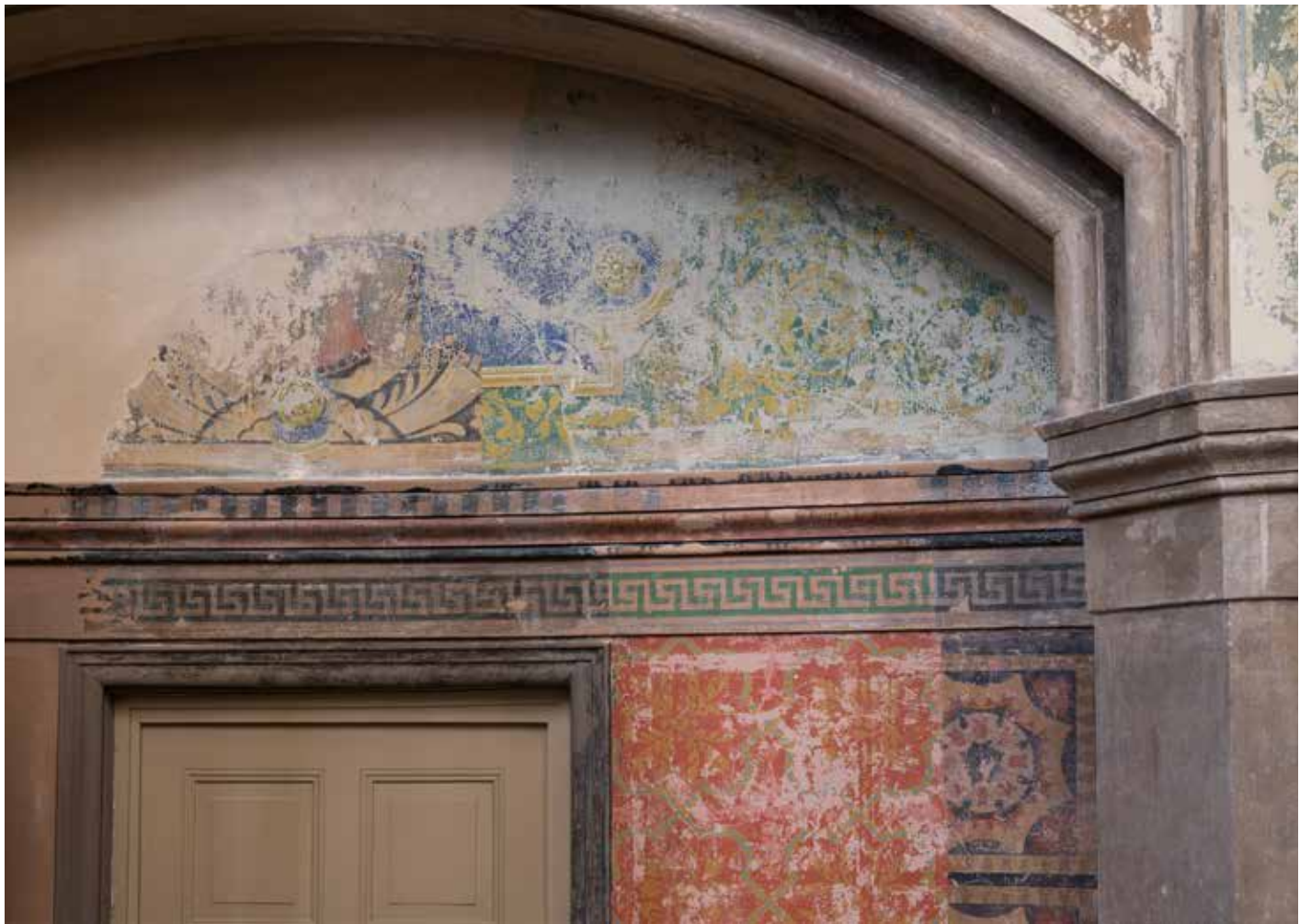
Krekeler Architekten Generalplaner, Sanierung der Zionskirche, Berlin 2009–2015, Foto: Stefan Melchior /Krekeler Architekten Generalplaner
